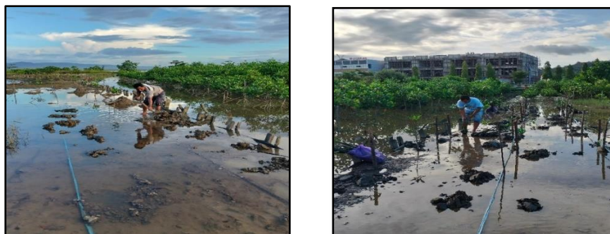
Gambar 3. Penggalian lubang dan pemasangan ajir
