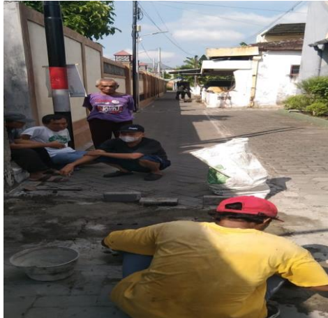
Gambar 2. Foto Pemasangan biopori, sumber dokumentasi Rt 36
