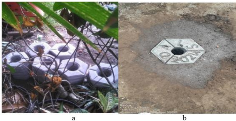
Gambar 3. a).Paving block penutup lingkaran mulut lubang biopori dan b) foto biopori yang selesai dipasang. Sumber: dokumentasi Rt 36
