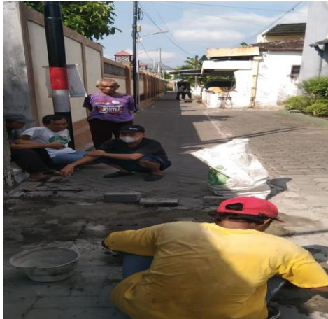
Gambar 2. Foto Pemasangan biopori, sumber dokumentasi Rt 36
